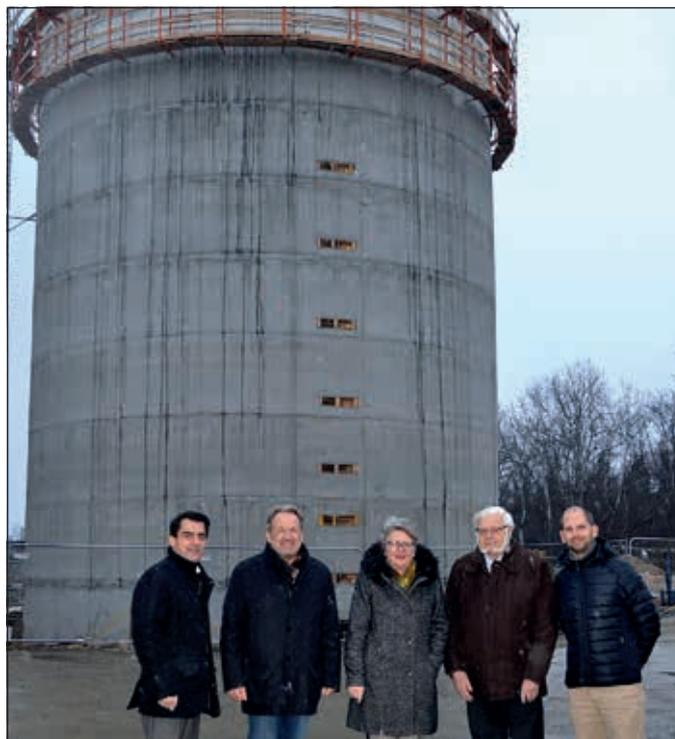
*Ungewöhnlich, aber wichtig: Im Turm der Kläranlage entsteht Biogas, das in einem Blockheizkraftwerk zu Strom umgewandelt wird.*
